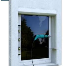
Percer le mur (selon la nature de celui-ci, brique, parpaing, enduit... et des fixations utilisées), prendre les précautions nécessaires afin de ne pas détériorer le produit
