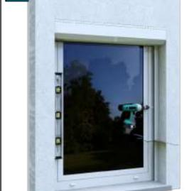
Fixer les coulisses, **IMPORTANT** : le type de fixation et dimensionnement doit être adapté au support, le niveau de protection répondra à la classification de corrosion en rapport à la norme **NF EN 1670**
