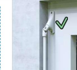
Insérer la tige d'attaque recoupée du renvoi de mouvement dans la menuiserie et dans le coffre
