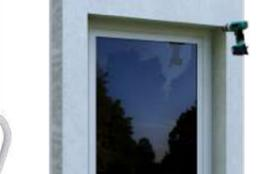
Reportez l'axe de sortie sur la menuiserie, attention à ce que cela ne gêne pas l'ouverture de la fenêtre en cas de manœuvre à tringle et percer
